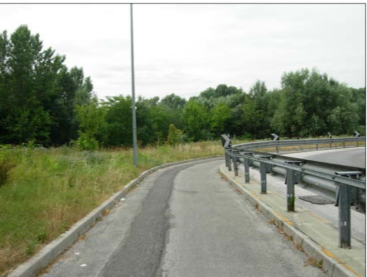
8 Ingresso da Via Pforzheim
