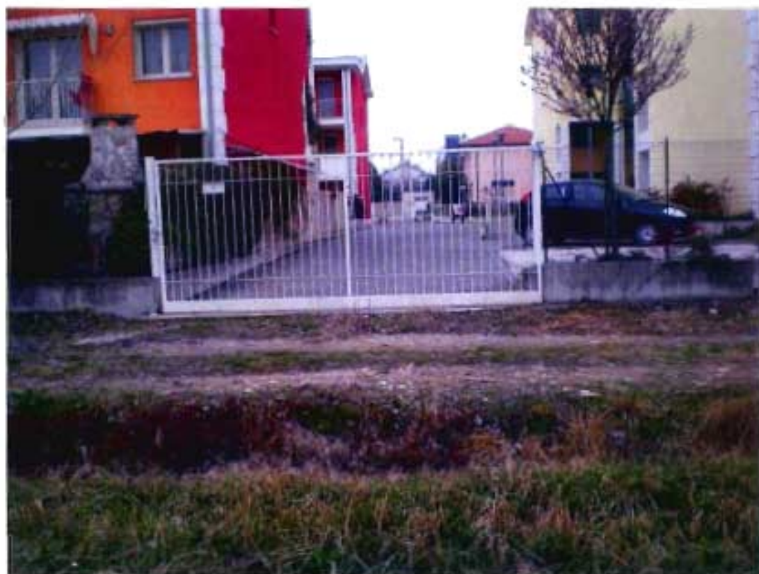
Foto 14 – Vista cancellata di accesso all'area da Via Sebastiano Trevisan
