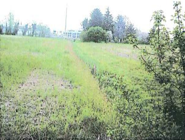
Foto 2 - Fossato del P.U.A. da tombinare con  $\Phi 120$  cm visto da ovest verso la Caveggiara (ad est)
