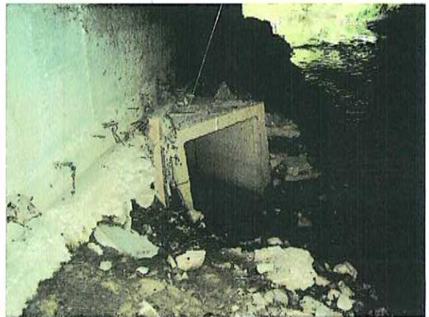
Foto 5 - Tombotto di scarico esistente 60 x 60 in Roggia Caveggiara sotto la rotatoria - ponte
