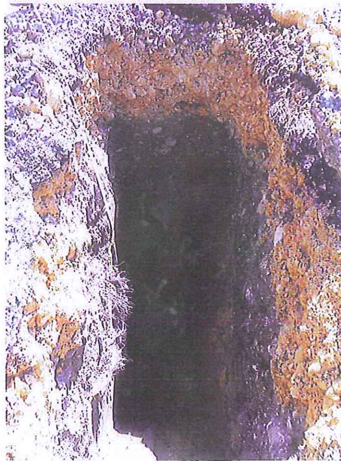
Foto 4 – Trincea geognostica 2, eseguita nel lato nord del piazzale
