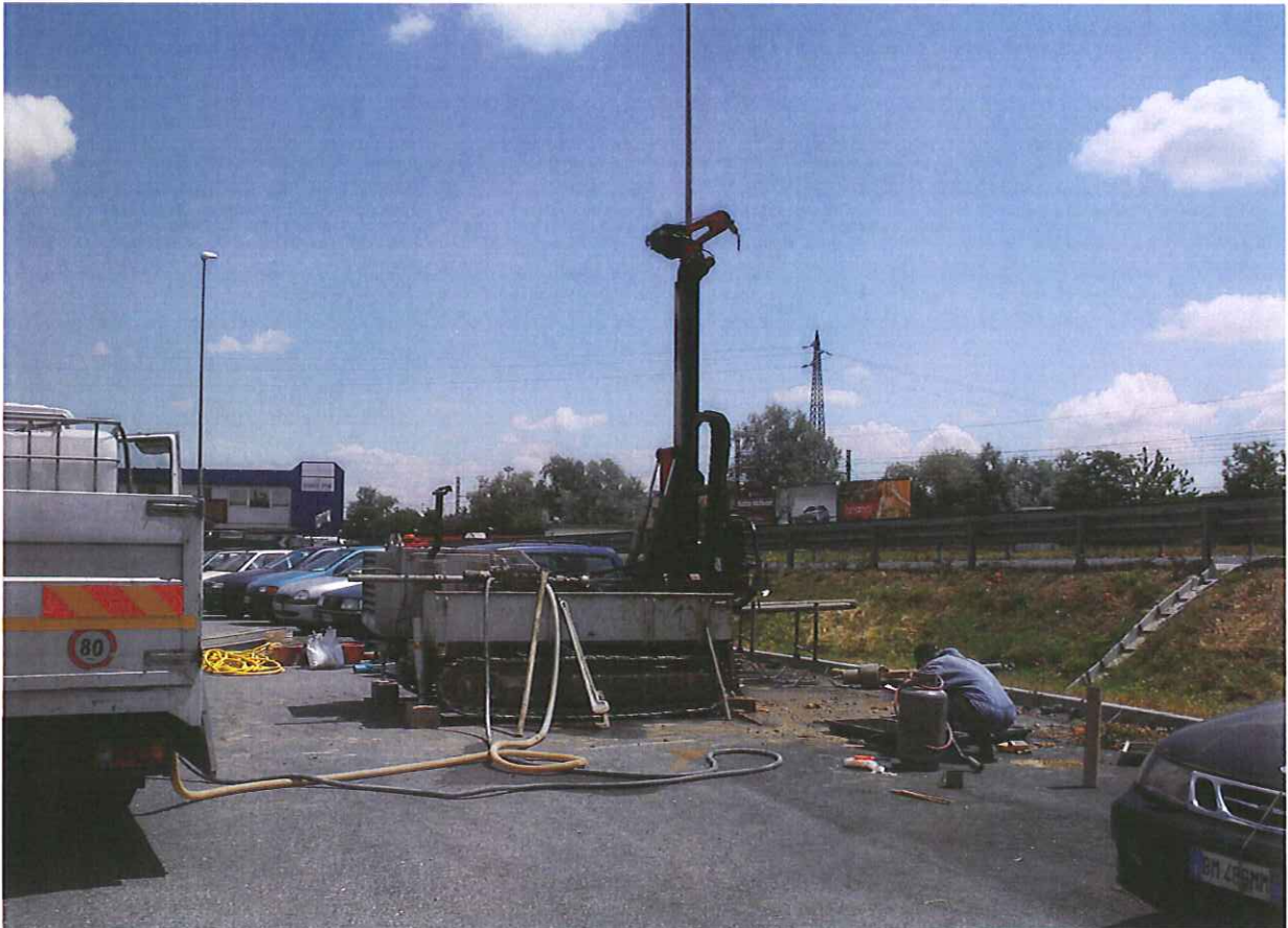
Figura 3 – Sonda GEO 305 durante l'esecuzione del sondaggio S3
