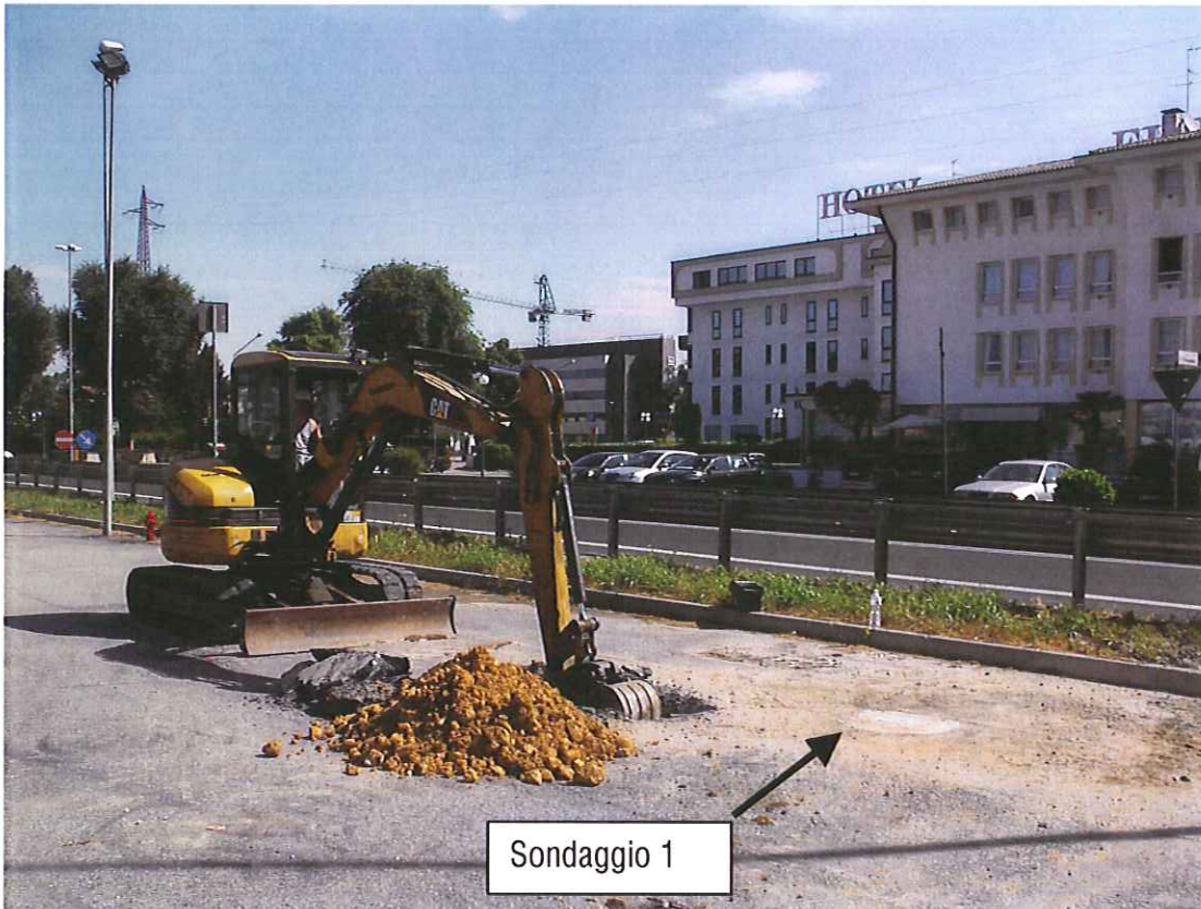
Foto 1 – Panoramica posizione del sondaggio S1
