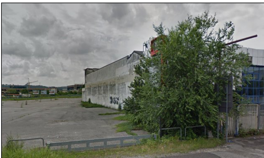
Foto n. 4 – vista ambito da SR11
