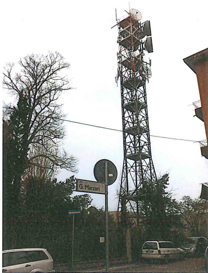
Vista del traliccio da via Marzari
