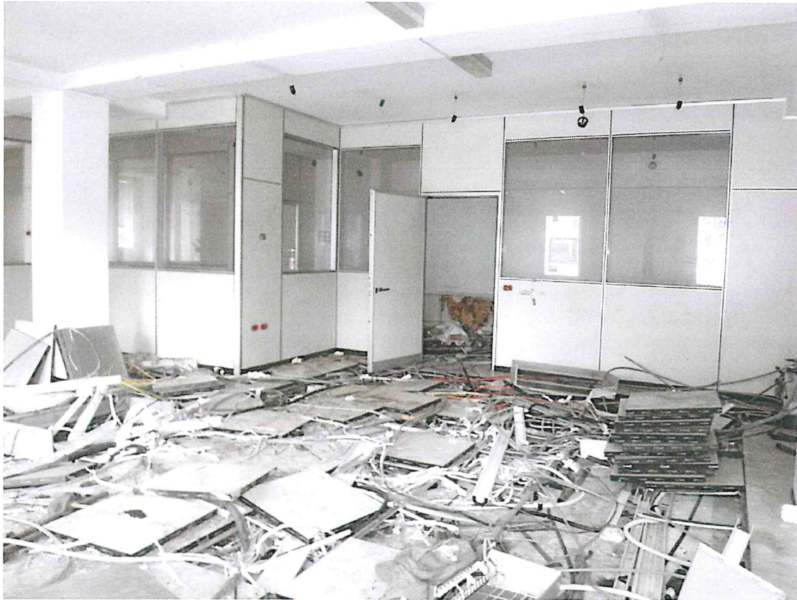
Vista dei locali all'interno
