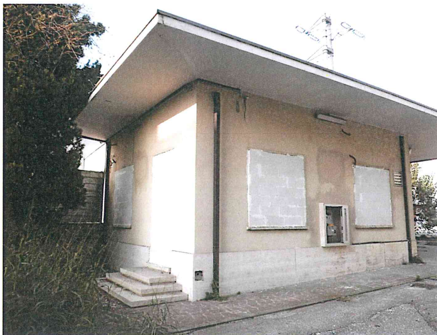
Vista del fabbricato dall'ingresso
