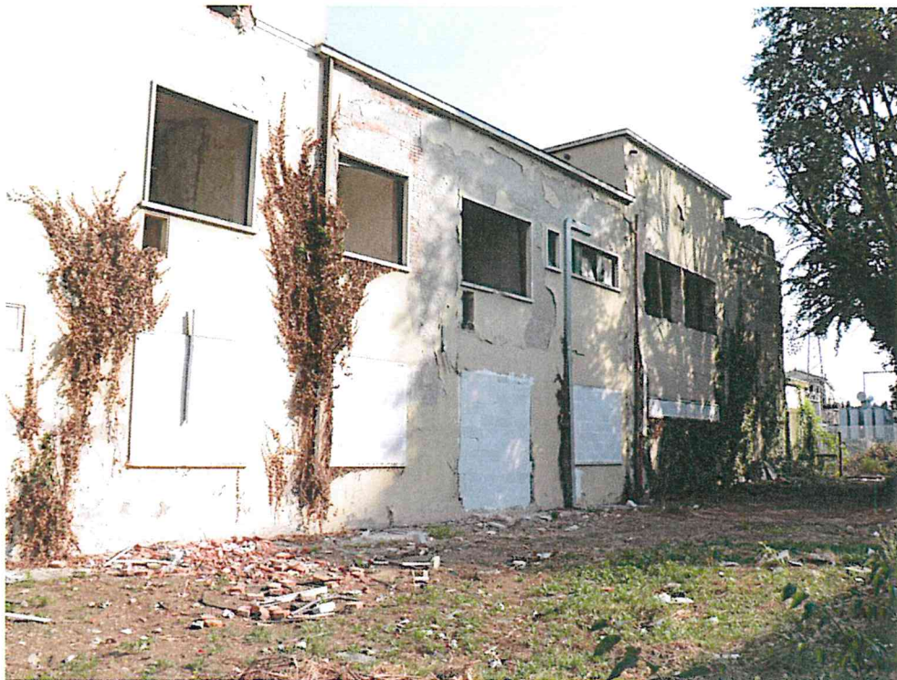
Vista del fabbricato da Sud
