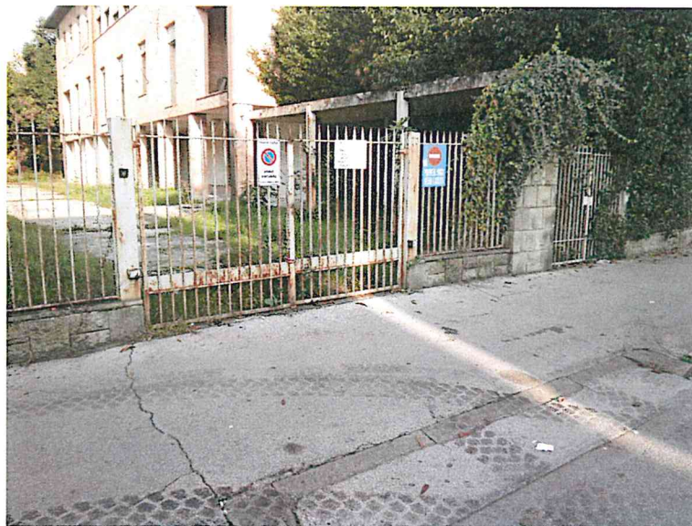
Vista di alcuni accessi lungo viale della Pace
