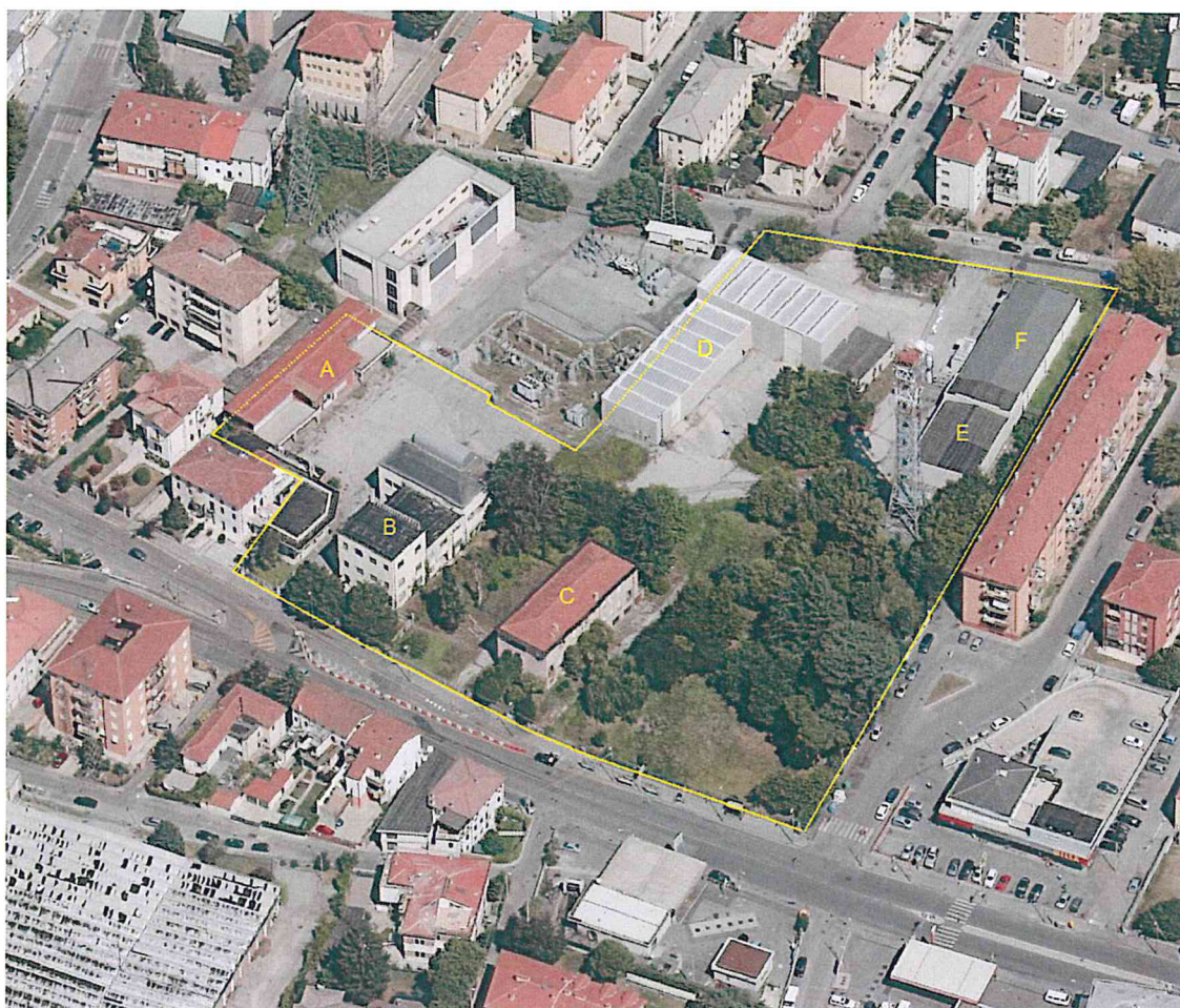
Vista aerea dell'area in oggetto
