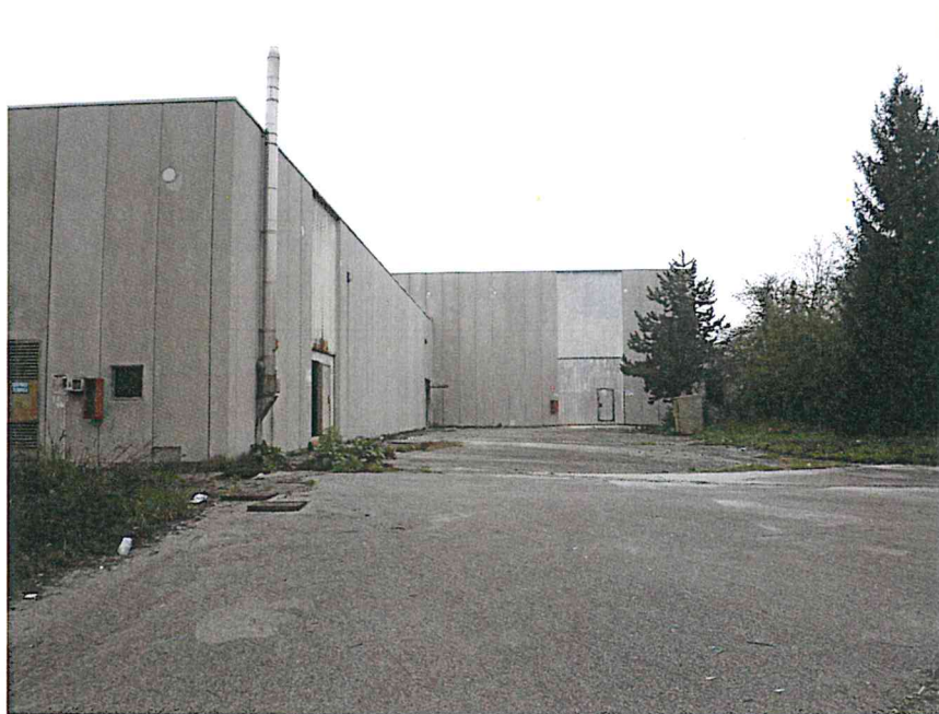
Vista generale del fabbricato “D” da Sud
