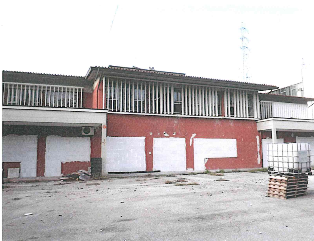
Vista del corpo centrale del fabbricato “A”
