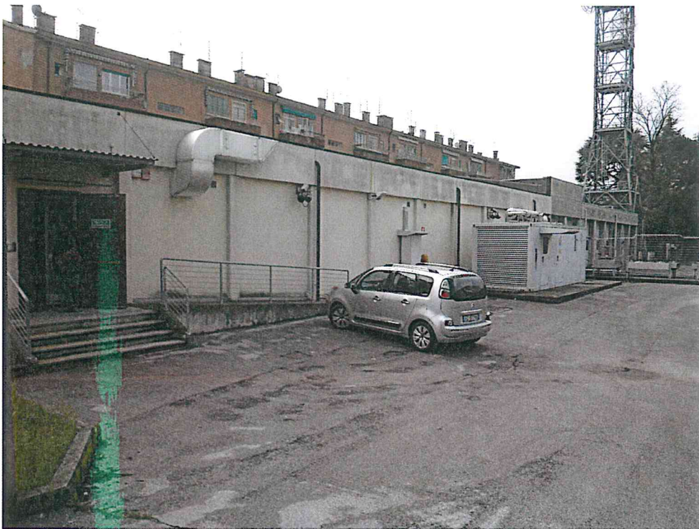
Vista del fabbricato “F” dall’ingresso a Nord
