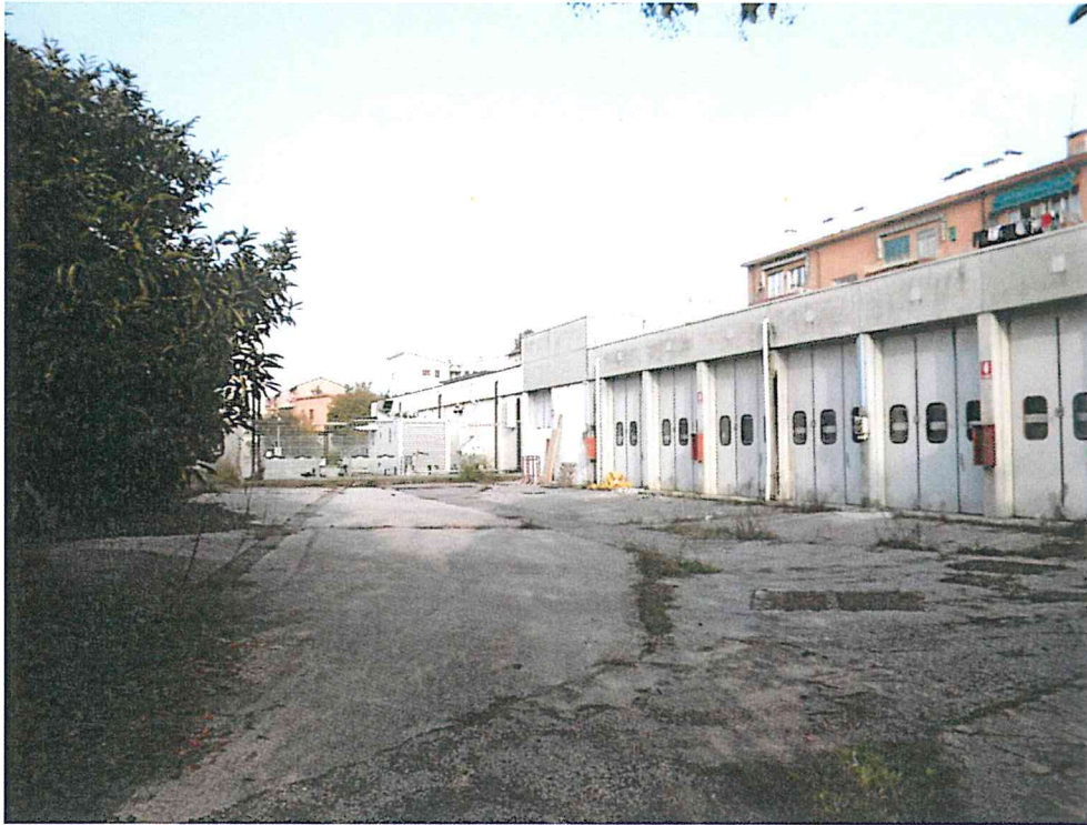
Vista del fabbricato “E” da Sud
