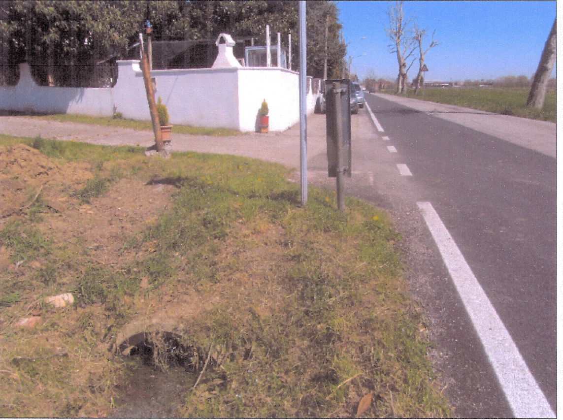
SCOLO INTUBATO/IMBOCCO ESISTENTE (NORD)
