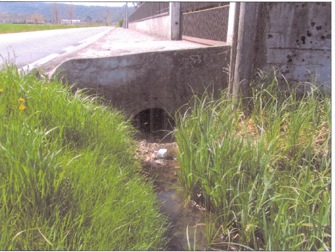
SCOLO INTUBATO/IMBOCCO ESISTENTE (SUD)
