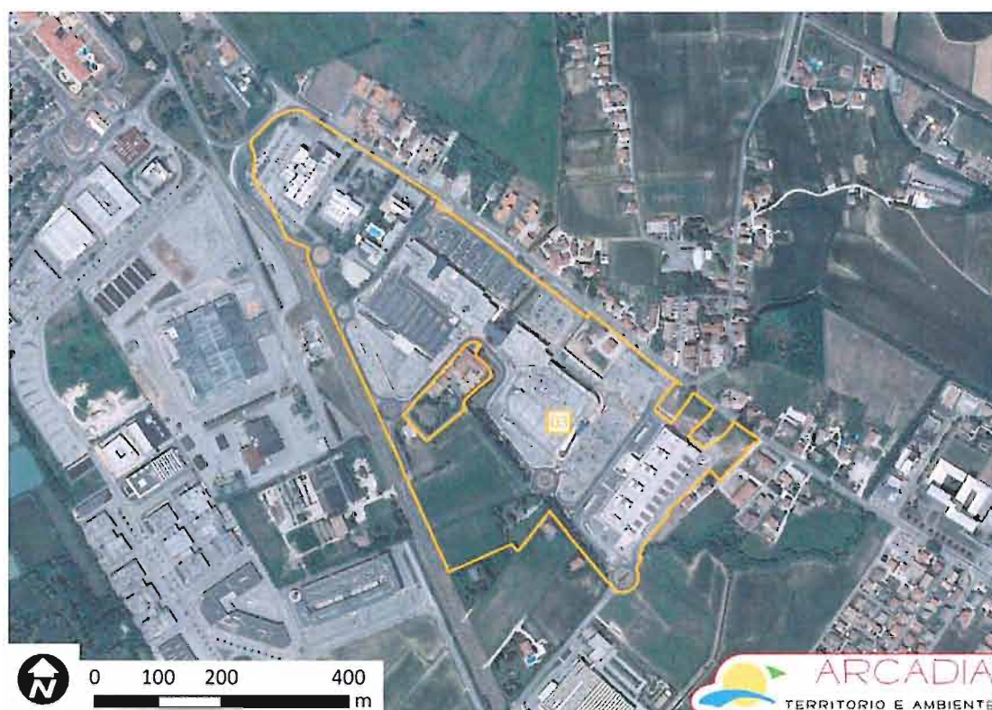
Figura 10: Individuazione del Parco Commerciale di Via Scolari e Viale della Serenissima.
