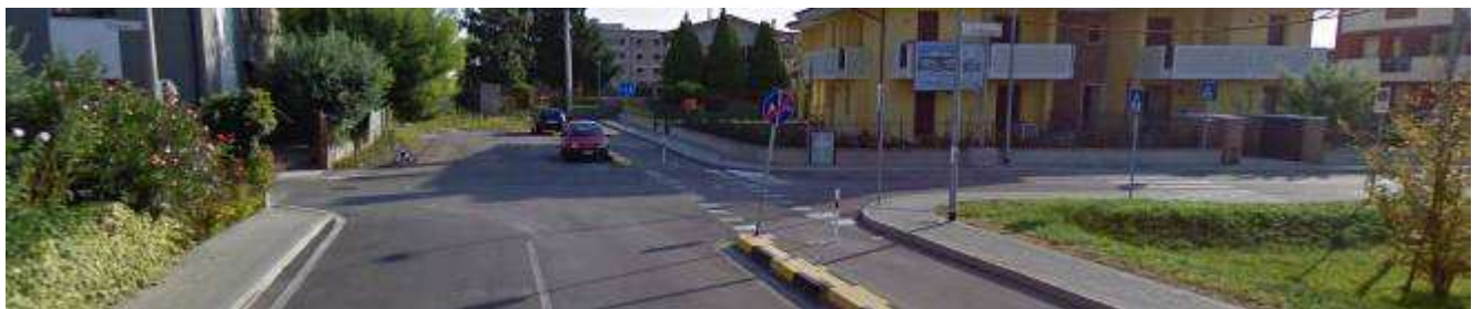
Segnaletica verticale errata e assenza delle strisce orizzontali per l'attraversamento: in questo caso il ciclista dovrà scendere dalla bicicletta e attraversare l'incrocio a piedi.
