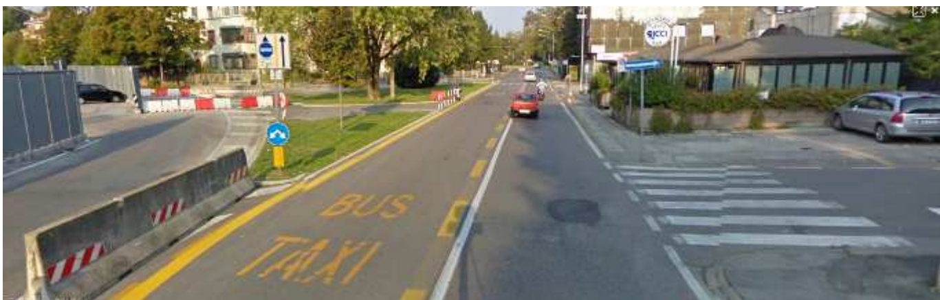
Preferenziale in viale Giangiorgio Trissino (zona Stadio) posta al centro della carreggiata..
