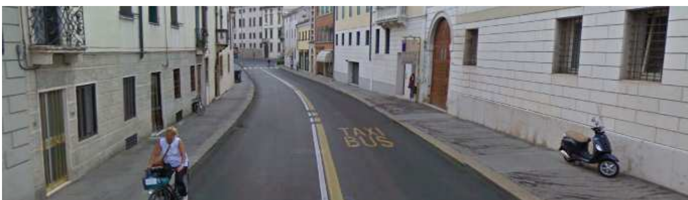
Corsia preferenziale in contromano lungo Contrà S. Francesco posta a lato strada con segnaletica orizzontale
